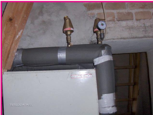
Neben der auf dem Foto beispielhaft gezeigten Isolierung waren weitere Ersatzteile, u.a. zwei Ausdehnungsgefäße, drei Umwälzpumpen, Entlüfter, Hähne, Ventile, Rohre und andere Materialien notwendig, um die Heizung "winterfest" zu machen.
