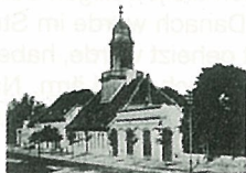
Erstes Gumbinner Rathaus erbaut 1739
